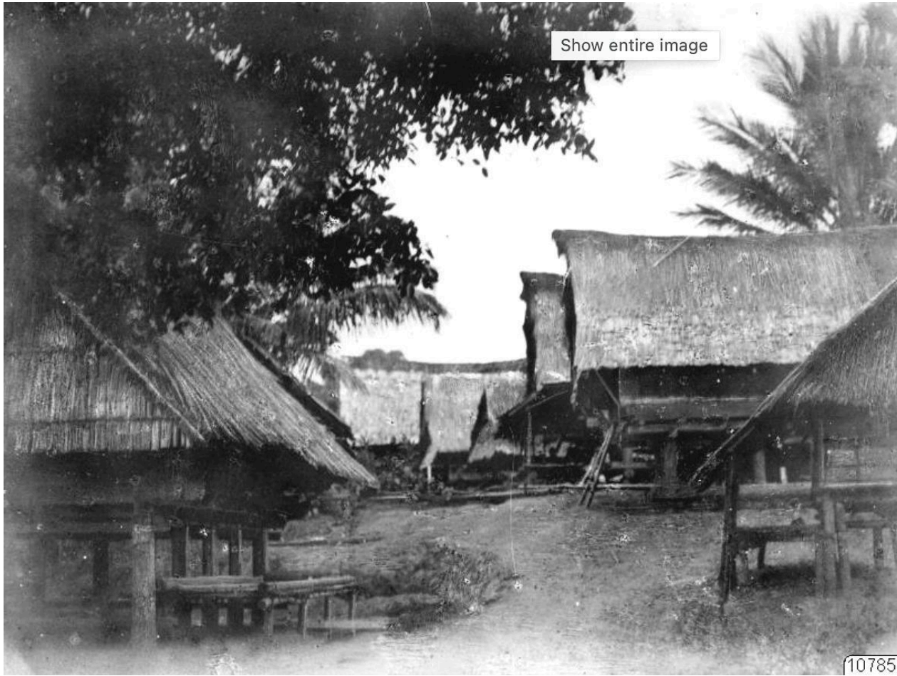
Gambar 7. Jalan desa Kantewu dilihat dari barat.
