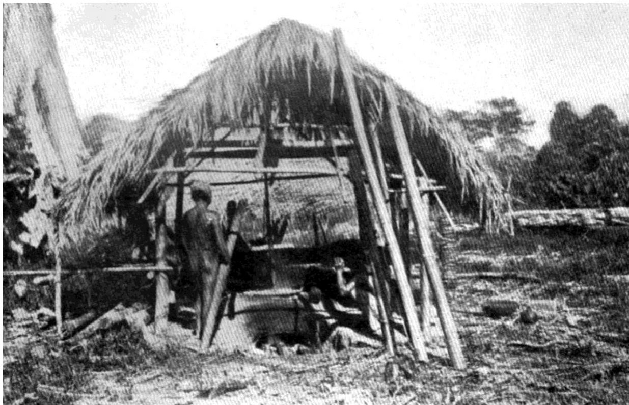
Ruang ketel tempat sari jagung dipekatkan menjadi gula; jus disuplai dalam tabung bambu di latar depan.
