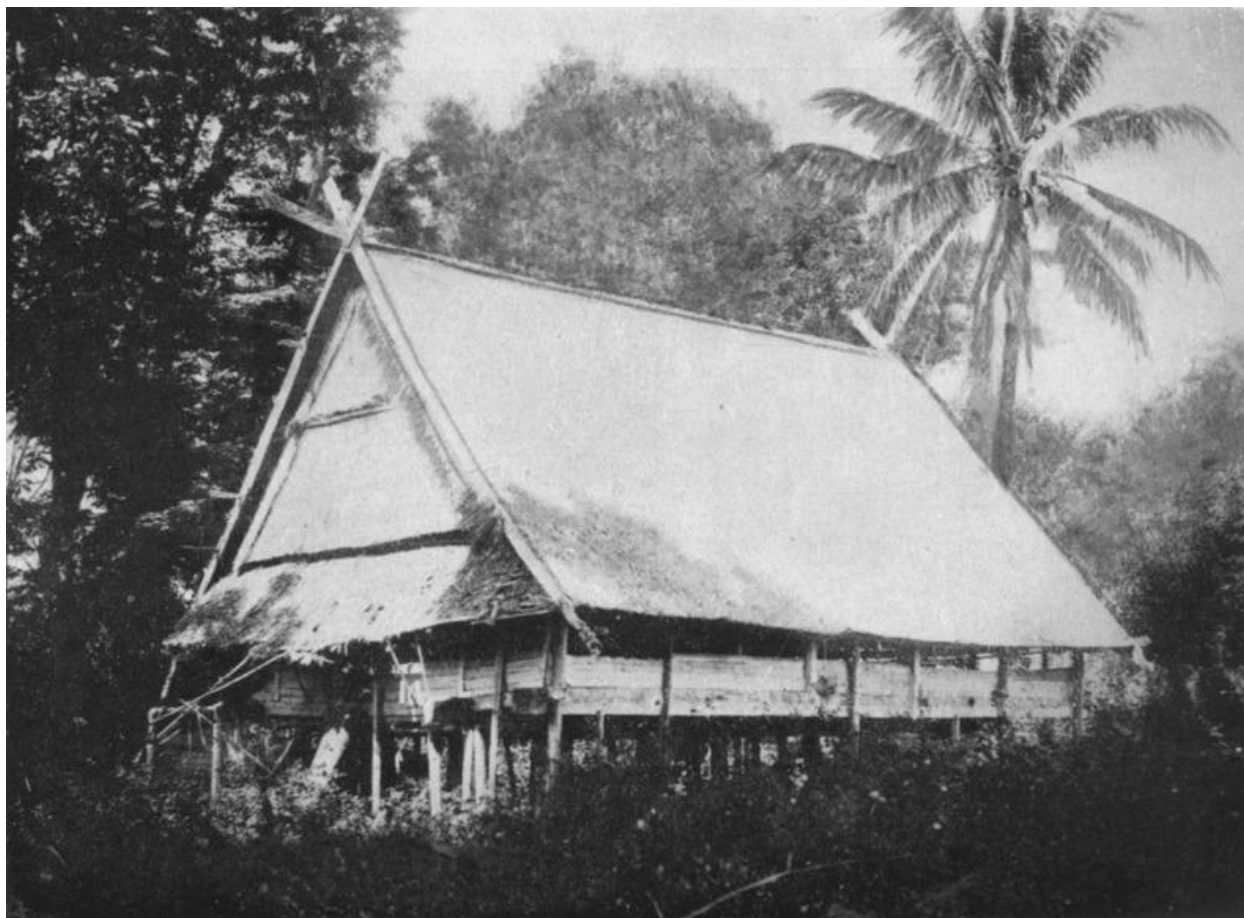
Kuil desa ( lobo ) Peura dalam kondisi bobrok.
