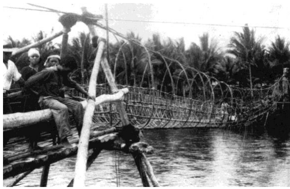
Jembatan rotan di atas Sungai Kalaena sedang dibangun.
