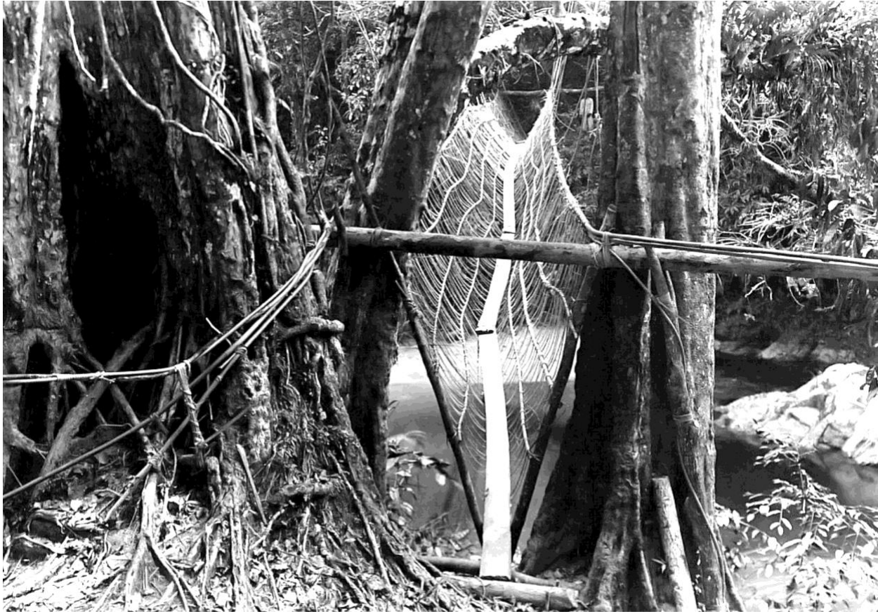
292. Jembatan gantung Rotang di atas Sungai Koro.
