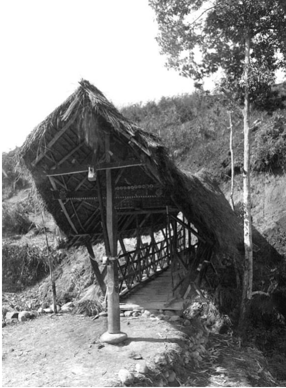
145. Jembatan di atas Salu Mua.
