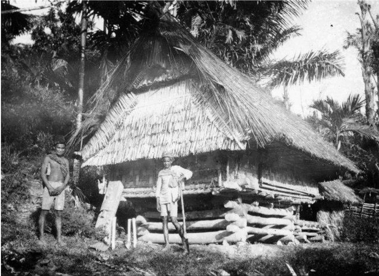
Rumah khas di Kulawi dengan rangka balok horizontal. Sumber foto.
