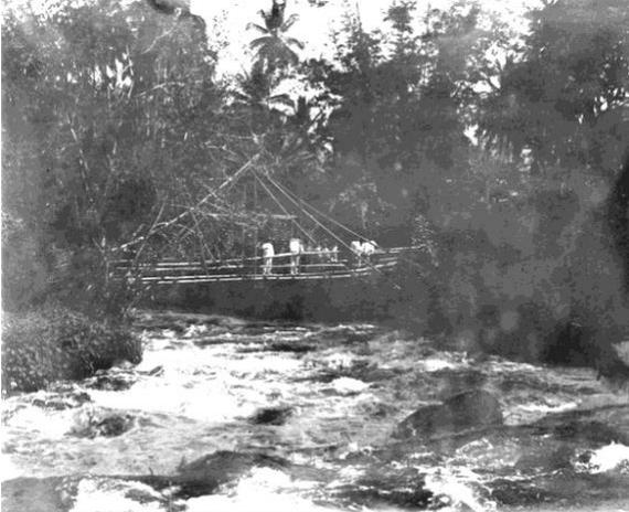
Gambar 60. Jembatan bentang yang terbuat dari tiang bambu di atas aliran sungai yang deras dekat jalan raya utama antara Manado dan Tondano, Minahasa. [Sumber foto.](#)
