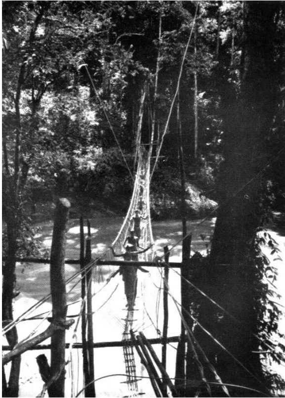
Jembatan rotan di atas Sungai Koro di Muu di jalan dari Gimpu ke Kentewu.
